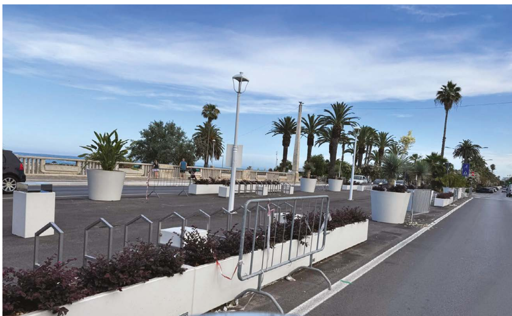
L'attuale stato dell'arredo sul ristrutturato ponte dell'Albula all'inizio del lungomare
